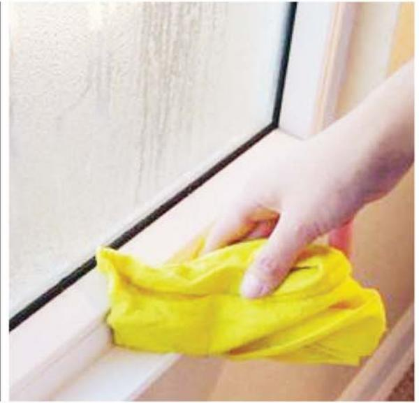
在秋冬季節，家中保持一定的濕度是合理的，能讓您感覺舒適，而且對人體健康也有好處。但室內濕度過高，則會造成門窗、天窗甚至牆壁出現凝結水珠現象，這是空氣中過多的水蒸氣遇冷液化的反映，顯示出您家中濕度可能過高了。如果濕氣嚴重，除了玻璃表面、牆壁出現凝結水珠，那它也可能在房屋的其他地方發生，祇是您未發現，這就可能引起油漆剝落、木制腐爛、發霉，而影響到您的整個房屋。
